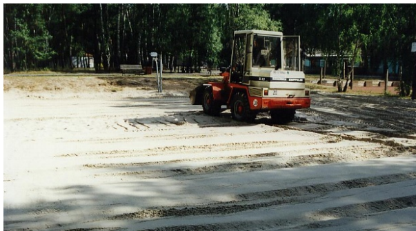
Planierarbeiten am Beachplatz
